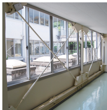
写真1 ノンコンプレッションブレース
